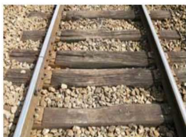
Rails courts sur traverses bois
