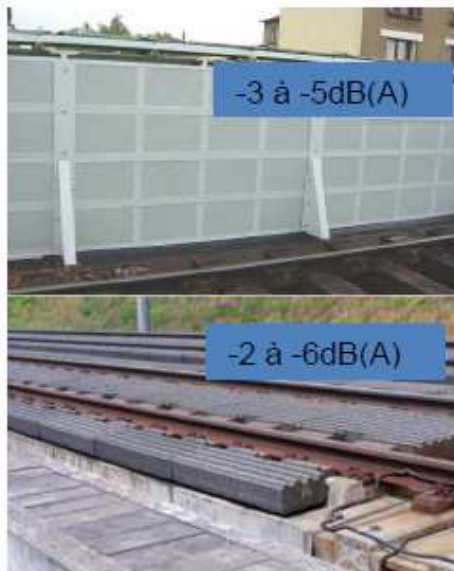
Illustration de plusieurs types de solution de réduction du bruit entre une source et un récepteur.
